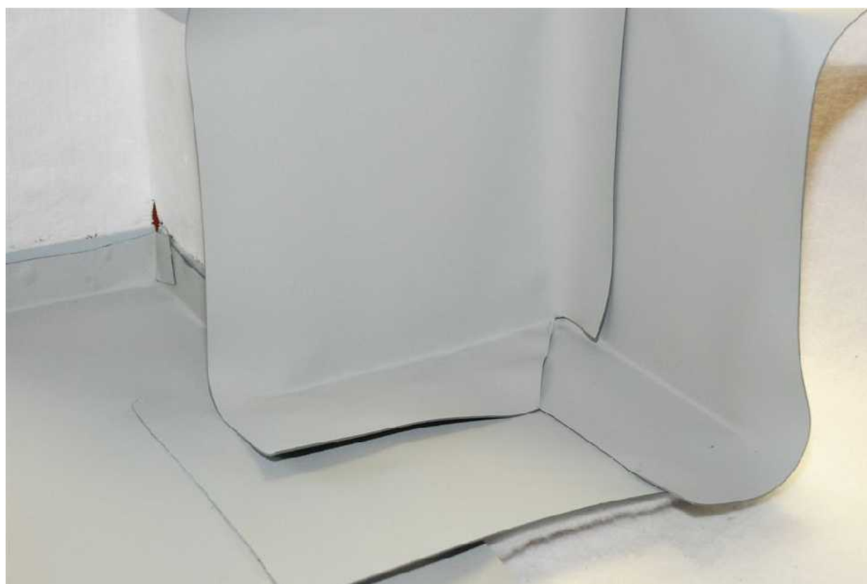
Obrázek 11.: Postup opravování hydroizolace v koutu
