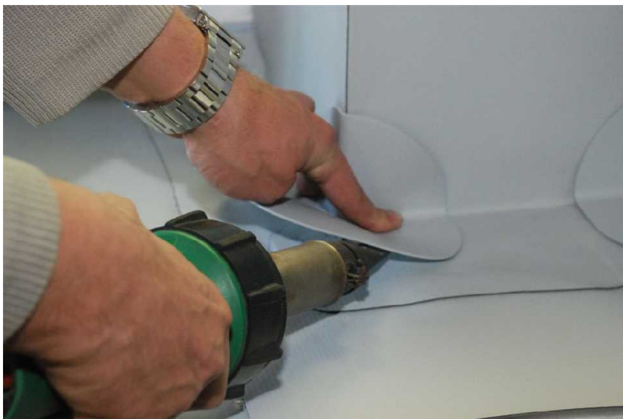
Obrázek 14.: Postup opracování hydroizolace na rohu
