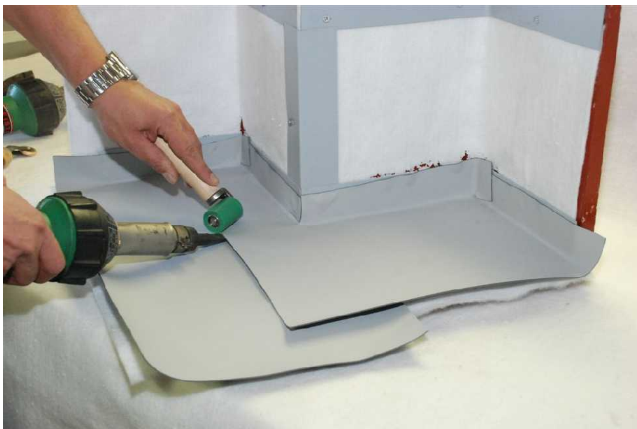
Obrázek 10.: Postup opravování hydroizolace na rohu
