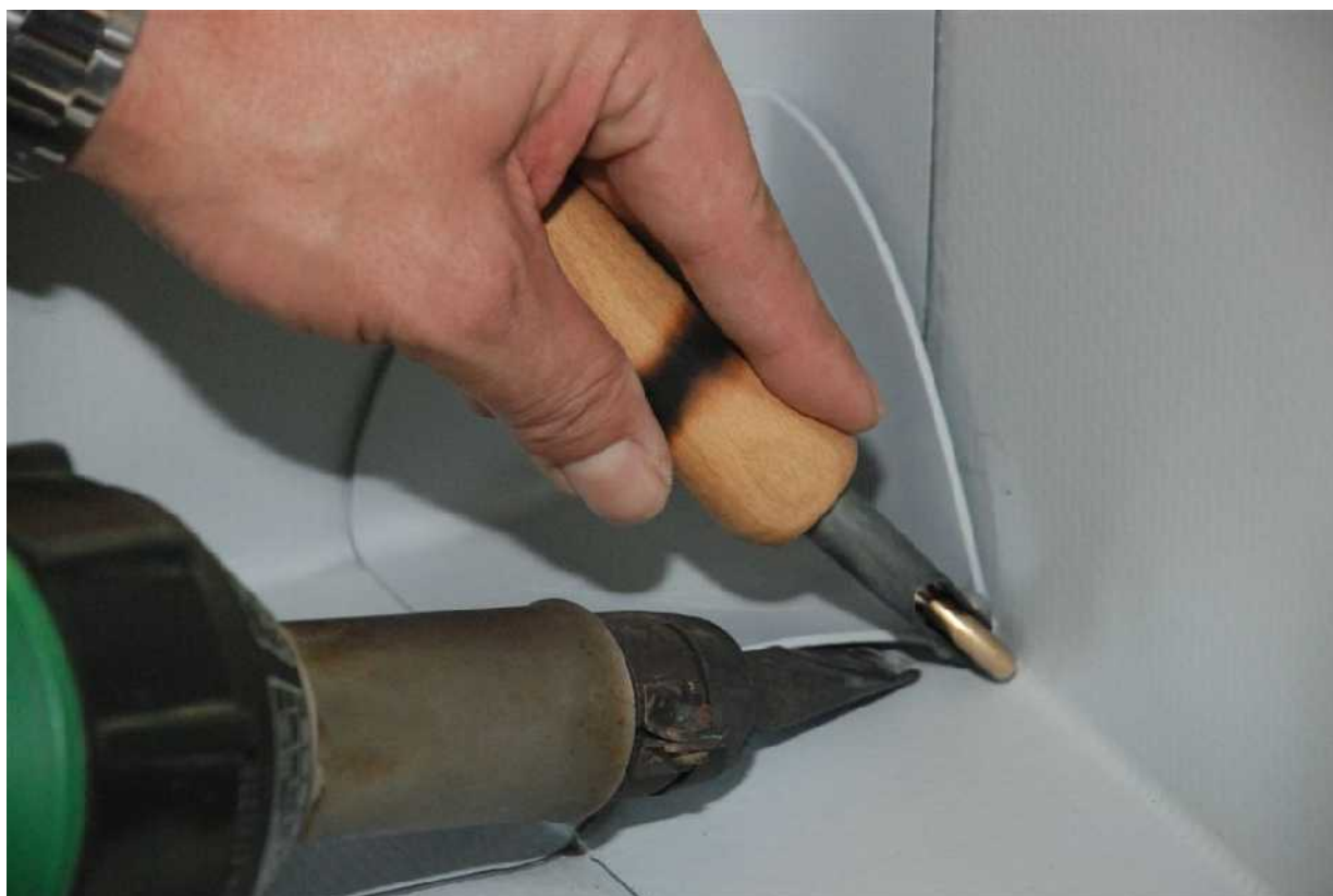
Obrázek 15.: Postup opracování hydroizolace v koutu
