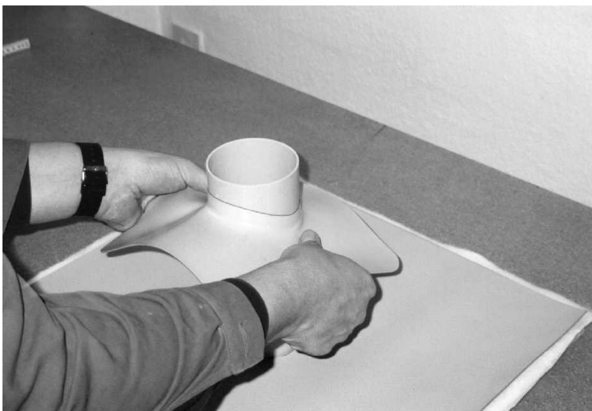
Obrázek 20.: Opracování prostupu - nasazení manžety na prostup
