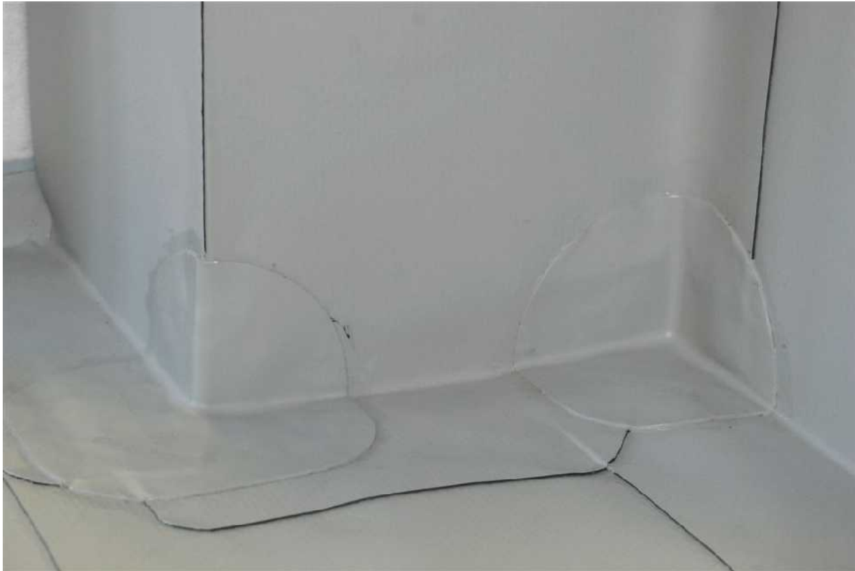
Obrázek 16.: Opracování hydroizolace v koutu a na rohu
