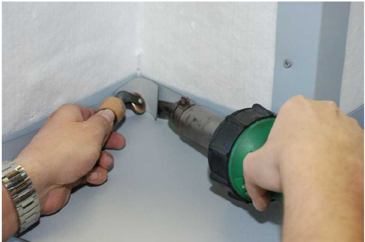
Obrázek 9.: Postup opracování hydroizolace v koutu
