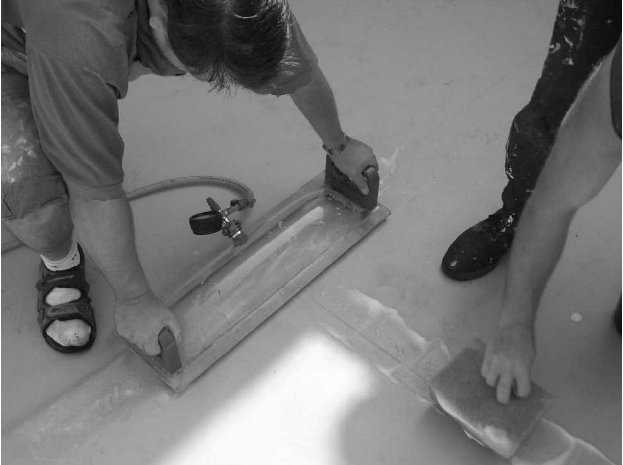
Obrázek 25.: Zkoušení těsnosti spojů vakuovou zkouškou
